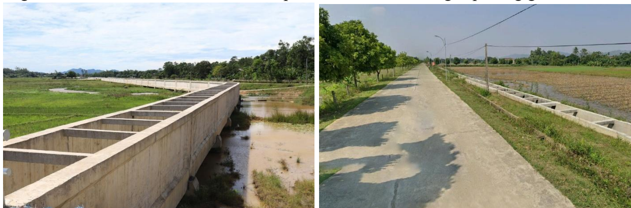
Hình 2-12: Hệ thống mương thủy lợi hiện trạng
