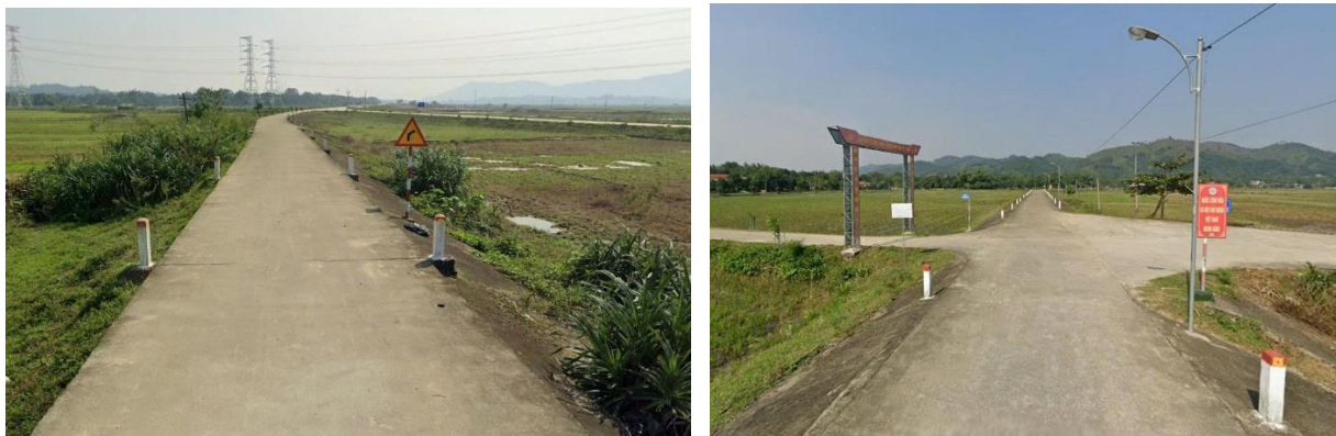
Hình 2-13: Hiện trạng các tuyến đường đê trên địa bàn xã
